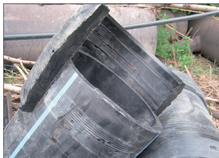
3. ábra. Hántolás nélkül hegesztett kötés nyomáspróba után
