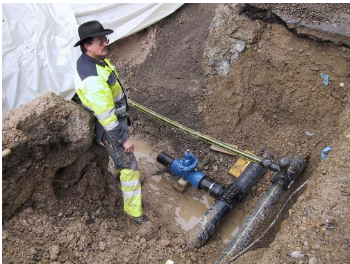
A hagyományos és a Saturn elágazó idomos megoldás. Egyszerű munkaárok kialakítás, a Saturn idom esetében. Gyorsan és költség-hatékonyan készíthető nagyméretű elágazás.
