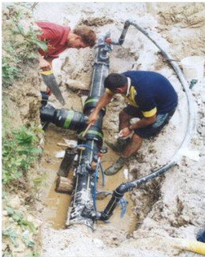
A hagyományos és a Saturn elágazó idomos megoldás. Egyszerű munkaárok kialakítás, a Saturn idom esetében. Gyorsan és költség-hatékonyan készíthető nagyméretű elágazás.
