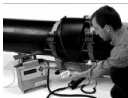
3. kép – Nagyméretű elektrofitting karmantyú helyes szerelése
