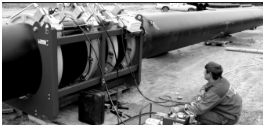
4. kép – A VÖRSAS Kft. d1000 mm átmérőjű PE csövet hegeszt tompan az Észak-pesti szennyvíztelepen
