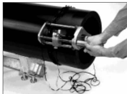
3. kép – Nagyméretű elektrofitting karmantyú helyes szerelése
