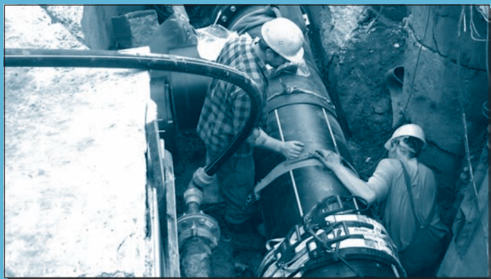
2. ábra: d560 mm méretű ELGEF Plus karmantyú hegesztése ivóvízhálózatban szűk munkakörülmények között
