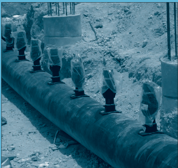
6. és 7. ábra: Leágazó nyeregidom függőleges és vízszintes beépítéssel
