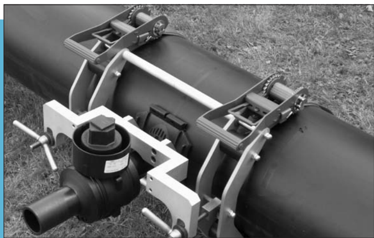
4. és 5. ábra: Az új Top-Load szerszám alkalmazás közben
