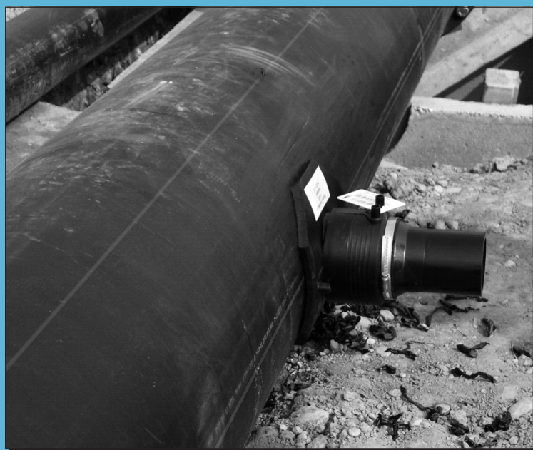
6. és 7. ábra: Leágazó nyeregidom függőleges és vízszintes beépítéssel
