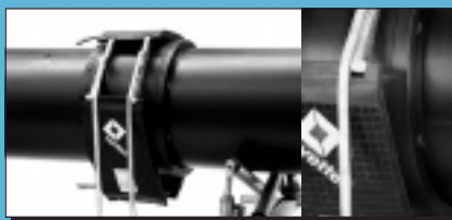
9. ábra: Nyomópárna illesztése a megfelelő helyre
