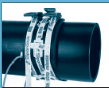
3. ábra: PE cső körkörösítése nyomópárna segítségével
